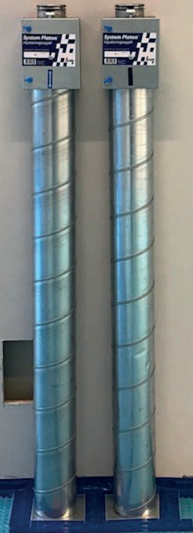
Bilden visar ett pågående objekt och zonavskiljande tätning mellan två golvsektioner. De två sugpunkterna kommer att anslutas till ett gemensamt nytt kanalsystem. Ovanpå Platonmattan Multi ska avjämningsmassa användas.
