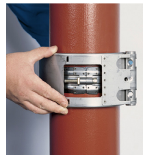
Trekk til de to boltene vekselvis med f.eks. en skralle-/fastnøkkel. Tiltrekkingmoment min 20 Nm.
