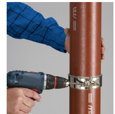
Trekk sammen med skrutrekker eller skralle-/fastnøkkel (6 mm unbrako).
