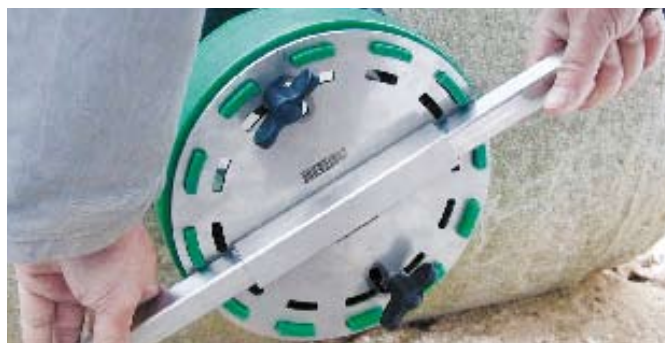
AWADOCK skruvkrona skruvas in i anslutningstätningen
