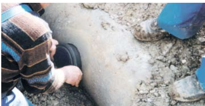
AWADOCK anslutningstätning förs in i borrhålet
