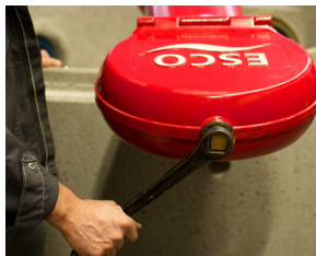
4. Når bolter er trukket til. Lukk igjen kapselen
