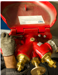
3. Når retningen på hydranten er ferdig justert strammes de fire boltene
