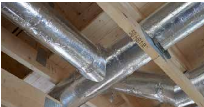
PAROC Hvac AirCoat, installasjon i villa.
