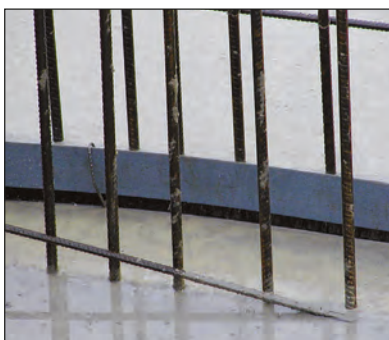
Sikker innfuging i betongen, maksimalt halv platebredde.
