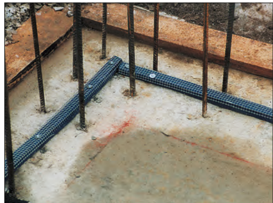
Montering med festegitter og spiker
