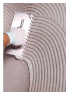
Påføring av første pusslag med Mapetherm AR1 GG
