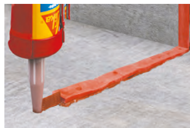
Tetningsmassen benyttes som lim for svellebånd.
