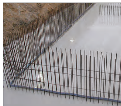
Sikker innfuging i betongen, maksimalt halv platebredde.
