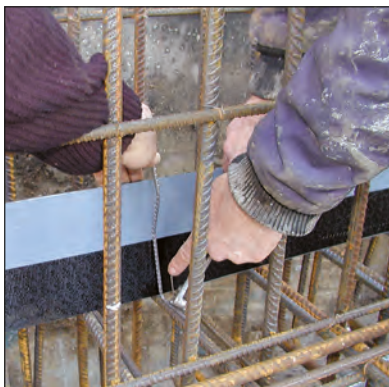
Montering med monteringsklemme på armeringen.
