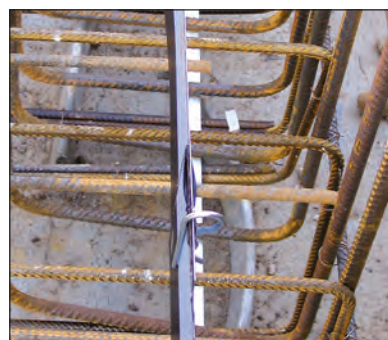
Overlapping og sikring med skjøteklemmer.
