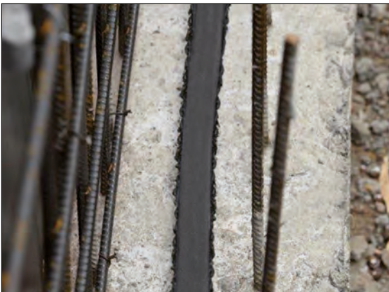
Montering med svellebåndslim
