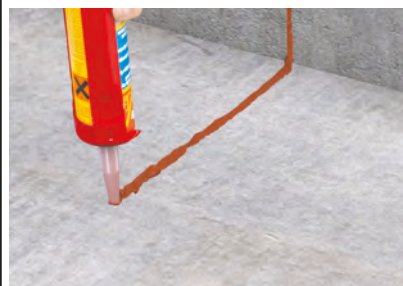
Bruk av kun tetningsmasse
