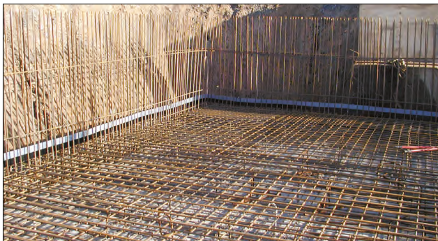
Trekk av det nederste silikonpapiret før støpingen.
