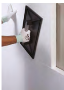
Press isolasjonsplaten hardt mot underlaget for å sikre god heft
