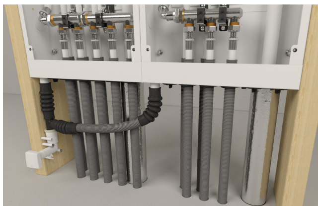
Tilkobling av Dreneringsrør
