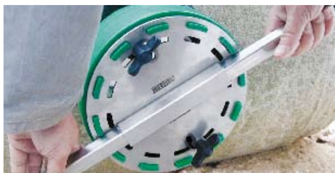
AWADOCK skruvkrona skruvas in i anslutningstätningen
