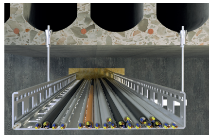
Kabelføringer i forspente hulldekker
