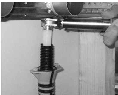
7. Entre kupling for hånd og trekk til med momentnøkkelen til det høres et klikk.
