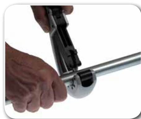
Figur 4: Kapping av røret
