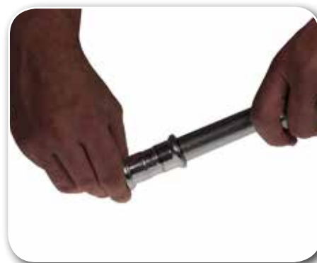
Figur 8: Sammensetning av fitting/rør
