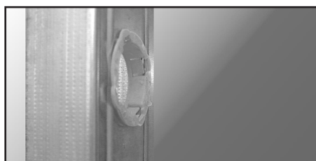
Lag et 35mm hull med f.eks. en hullstanse.
