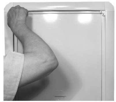
Rammen monteres med medfølgende skruer utenpå ferdig vegg
