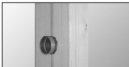
Påse at spikeravviserens skjøter står vertikalt og går igjennom stender så spor for fikseringsklammer er synlig.
