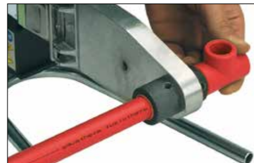
Oppvarming av rør og rørdel
