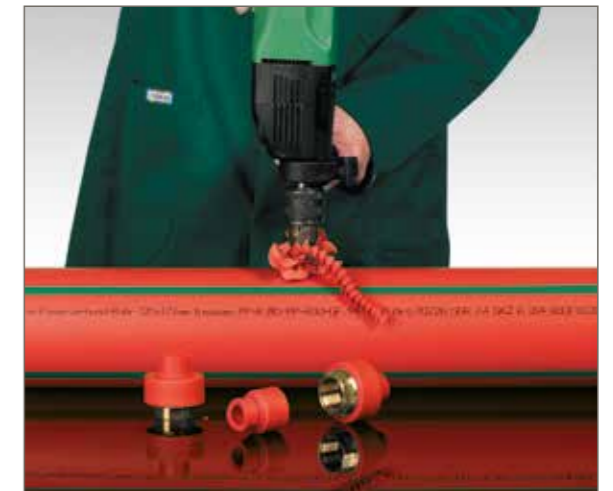
Gjennom boring av røveggen
