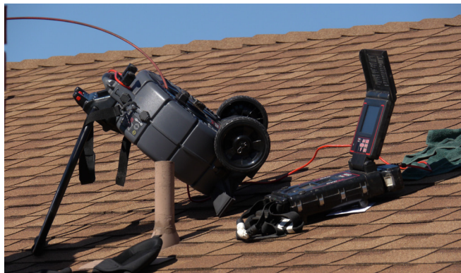
Figur 16 – rM200 og dens støtteben under en taginspektion
