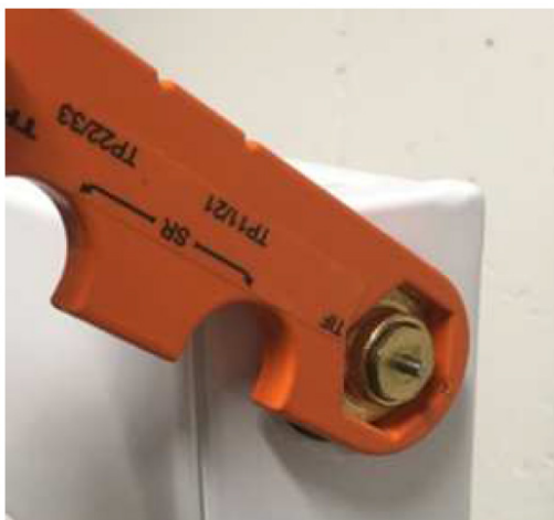
Demontering av ventilinsats
