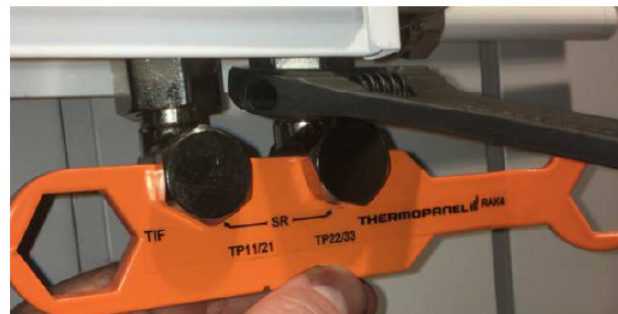
Positionering av SR avstängningar vid åtdragning
