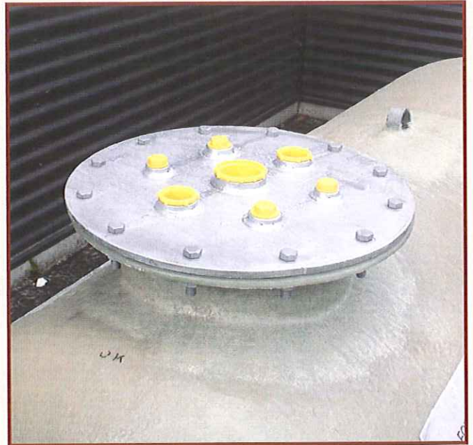
På den nye modellen er muffebrettet på tankmantelen erstattet med tanklokk, Ø 300 mm.
