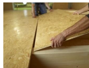
(Bilde 3): Ovnstørket, høvlet
