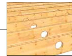
Hulltaking for ventilasjon
