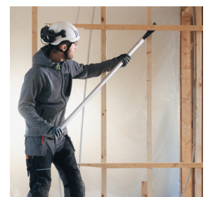
Skaftet er hult og produsert av aluminium med spesiallegering som gjør det både sterkt og lett i vekt.
