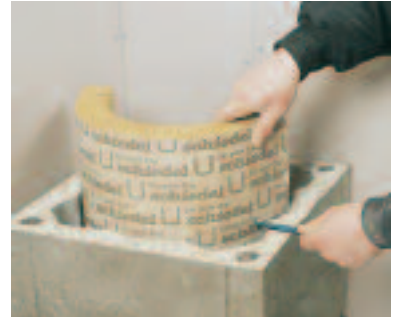
Sett i en isolasjonsplate, kutt denne med vedlagt sagblad. Resten av isolasjonsplaten brukes på andre siden.
