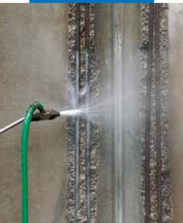
Rengjøring av armering
