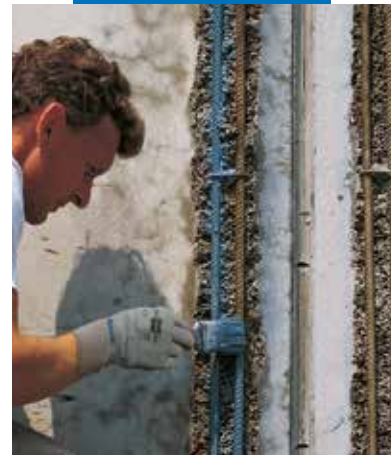
Påføring av Mapefer
