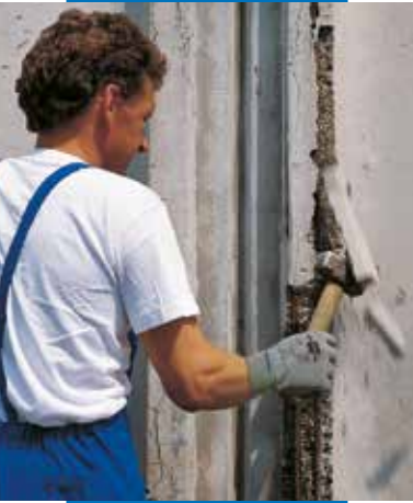
Fjerning av nedbrutt betong
