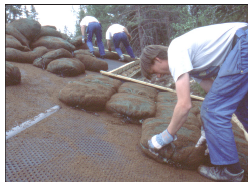
Rillene gir friksjon for torvlaget.
