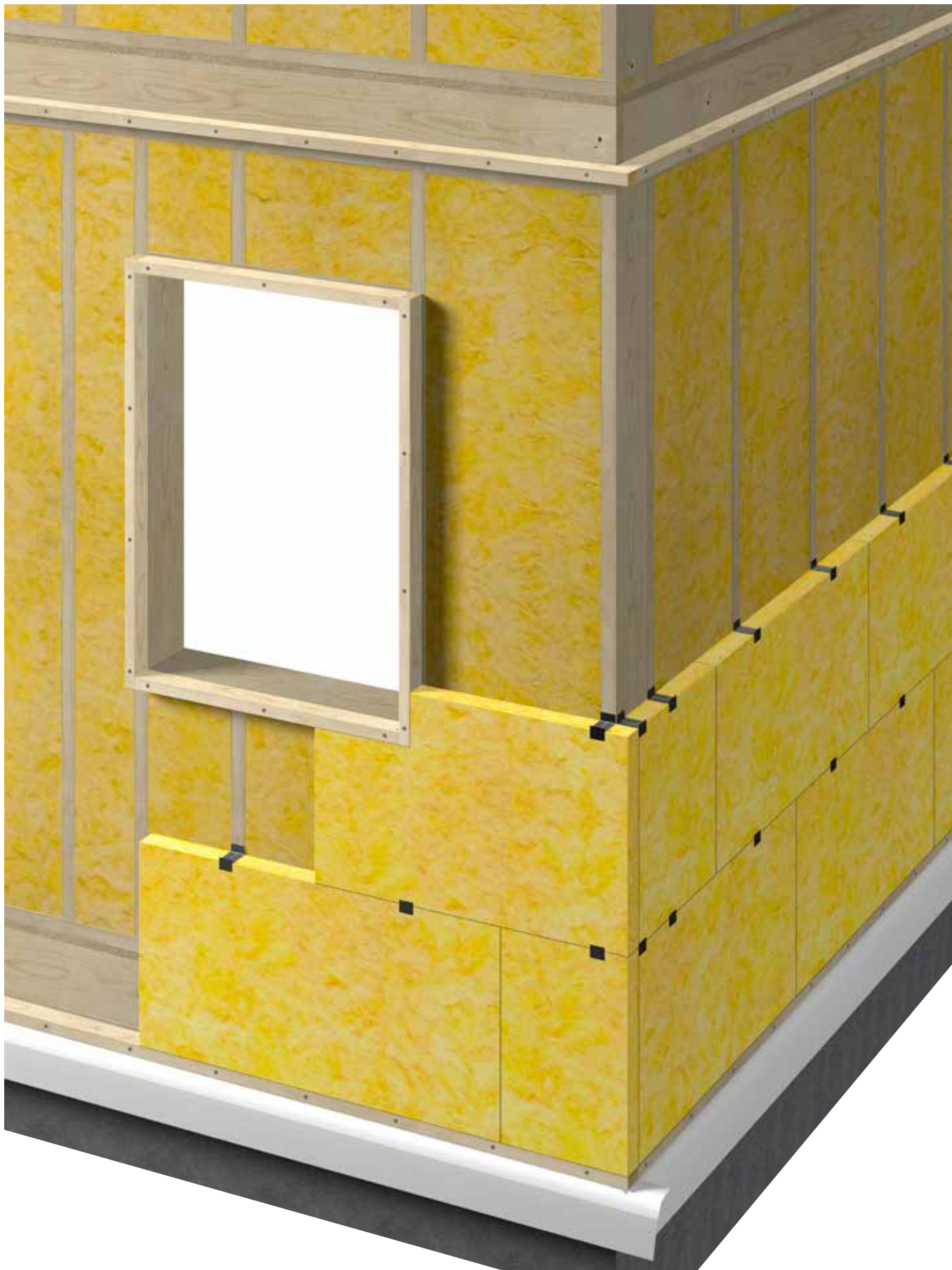
Veggplate 31 og veggplatebraketter på plass
