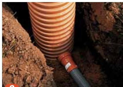
2 Montér drensrør i drenstilkobling.
