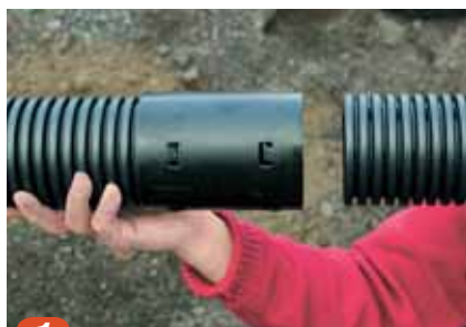
1 Skjøtemuffe monteres inn på den ene rørenden.
