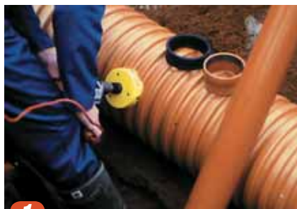
1 Det bores hull med 127 mm hullsag.
