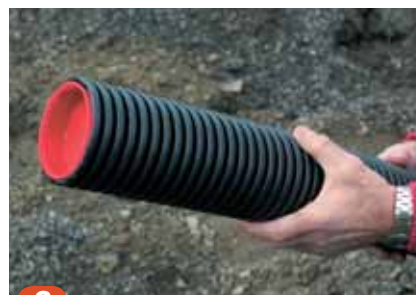
3 Benytt endedeksel for unngå masse i ledningen.
