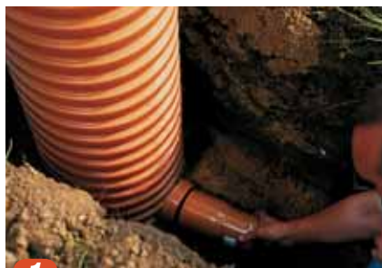
1 Drenstilkobling benyttes ved for eksempel husdreneringskum.
