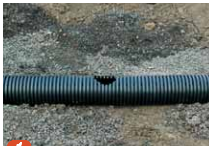
1 Eksisterende rør frilegges og hull skjæres i rørets øvre del.
