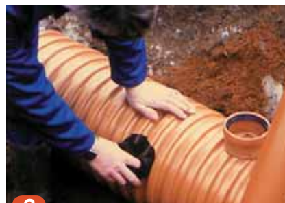
3 Muffen skyves på plass og drenstilkobling kan monteres.
