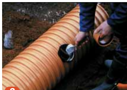
2 Gummiring monteres og påføres glide-middel.
