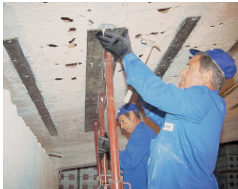
Montering av metallplate for konstruktiv forsterkning
