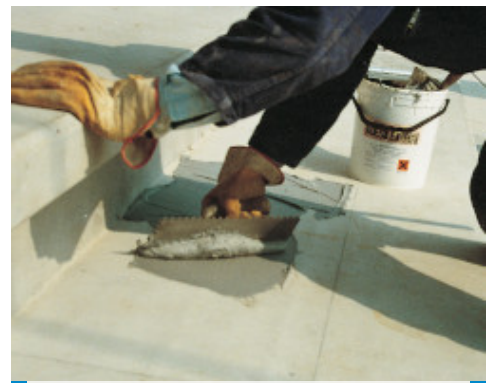
Påføring av Adesilex PG1 med tannsparkel for strukturell liming av støpte trinn
