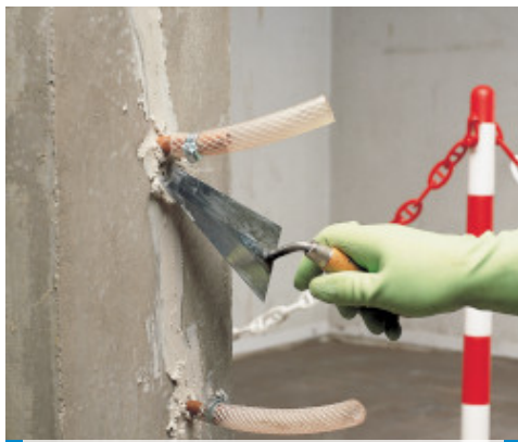
Innfesting av rør til injisering, og tetting av strukturelle sprekker
