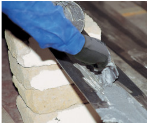
Påføring av Adesilex PG1 på metallplate
