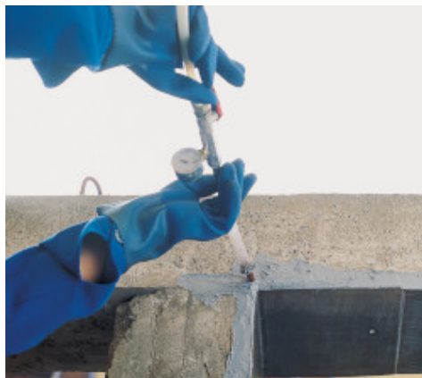
Søyle påført med Adesilex PG1
