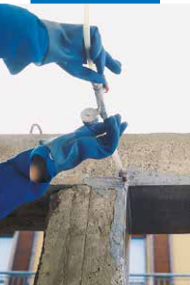
Søyle påført med Adesilex PG1
