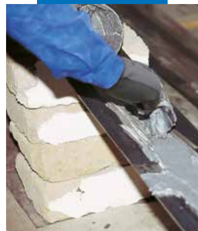
Påføring av Adesilex PG1 på metallplate
