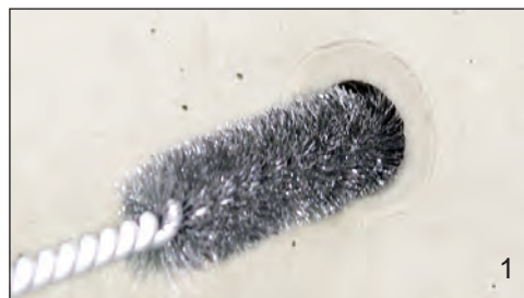
Rengjør avstandsstykket hvis det er tilsmusset
