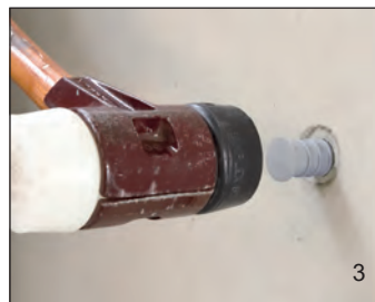
Slå inn STOPPER med gummihammer
