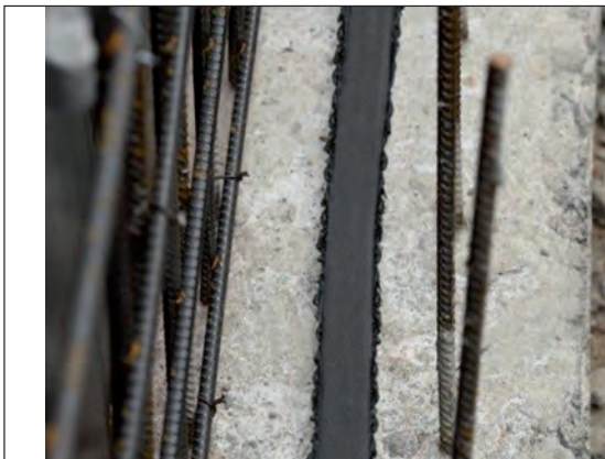
Montering med svellebåndslim
