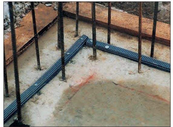
Montering med festegitter og spiker
