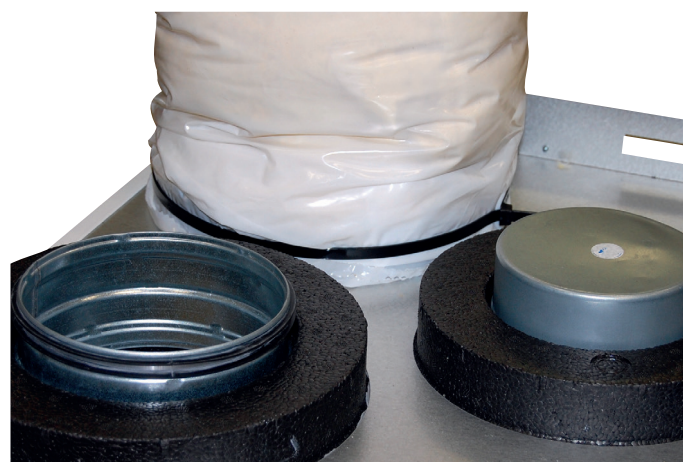
Ferdig montert kanal.
