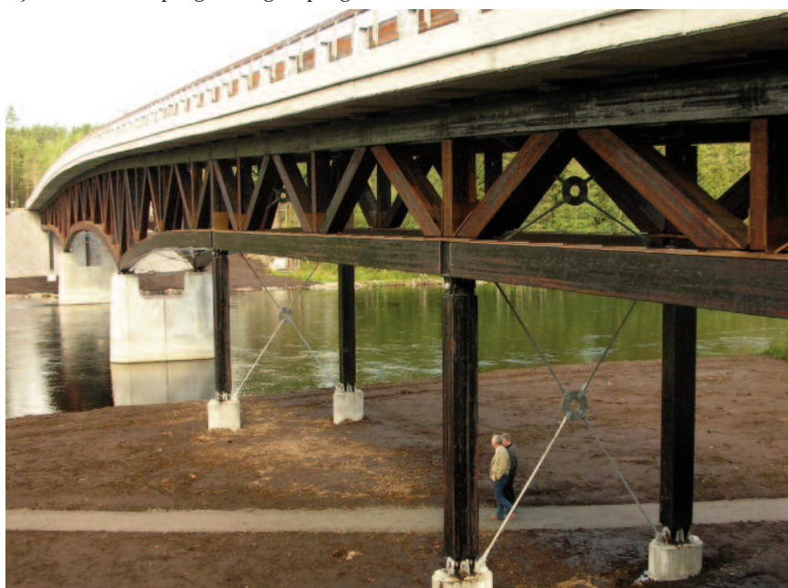
Kjørebrosaltimpregnert og impregnert med kreosot.
