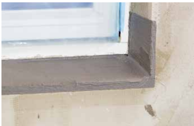
Mapelastic påført ved sålbenk.
