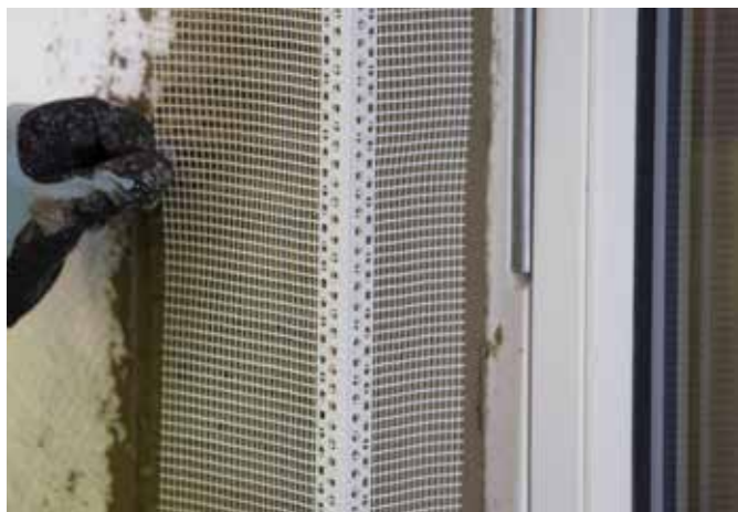
Plassering av Mapetherm Corner Profile ved vindussmyg.
