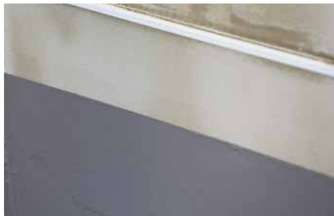
Mapelastic påført i sokkelområde.
