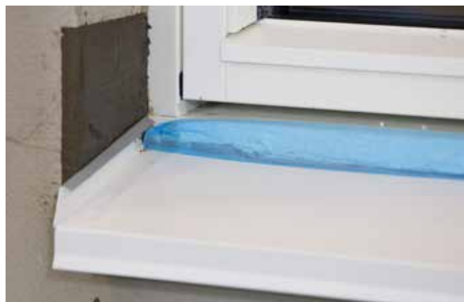
Sålbenkbeslag montert.
