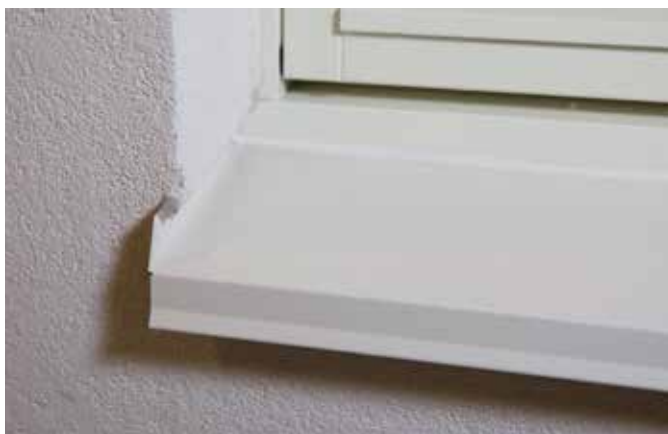
Mapelastic påført ved sålbenk.
