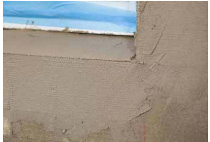
Vindus-detalljer og hjørnearmering er pusset inn med grunnpuss.
