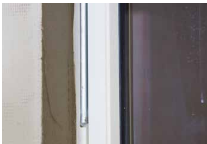
Ferdig innpusset Mapetherm Profil W .
