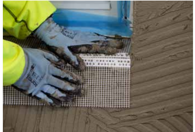
Ved pussing av sålebank monteres Mapetherm Corner Profile eller Mapetherm Corner Flexible .
