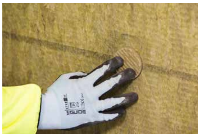
Trykk på plass pluggisolasjon.
