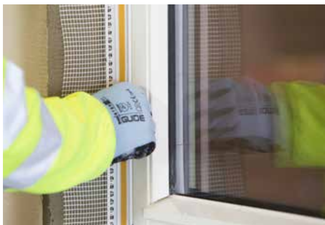
Plassering av Mapetherm Profil W . Profilen limes til vinduskarmen ved å fjerne beskyttelses-tapen på profilen.
