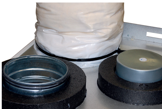
Figur 21 Ferdig montert kanal
