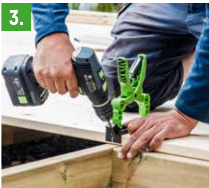
3. Vinkle drillen slik at batteriet ikke slår mot bjelkelaget. På den måten er det mindre risiko for feilmontering samt skader på monteringsverktøy og bits.
