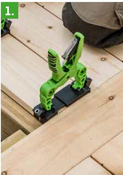
1. Klem fast monteringsverktøyet.
