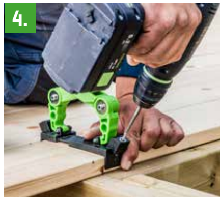
4. Monter med HDS-bits – begynn alltid med den ytterste skruen.
