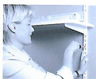
Trinn 6 Legg en hylleplate på knektene og kontrollér med et vater at veggskinnene er i lik høyde. Bor og skru fast veggskinnen.
