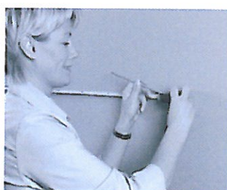
Trinn 5 Gjør klart for neste veggskinne. Mål og merk av c/c avstand, ikke mer enn 900 mm mellom veggskinnene. Hekt en knekt på veggskinnen (som ennå ikke er montert) i samme spor som den første. Pass på at veggskinnene står parallelt slik at knektene kommer i samme høyde.
