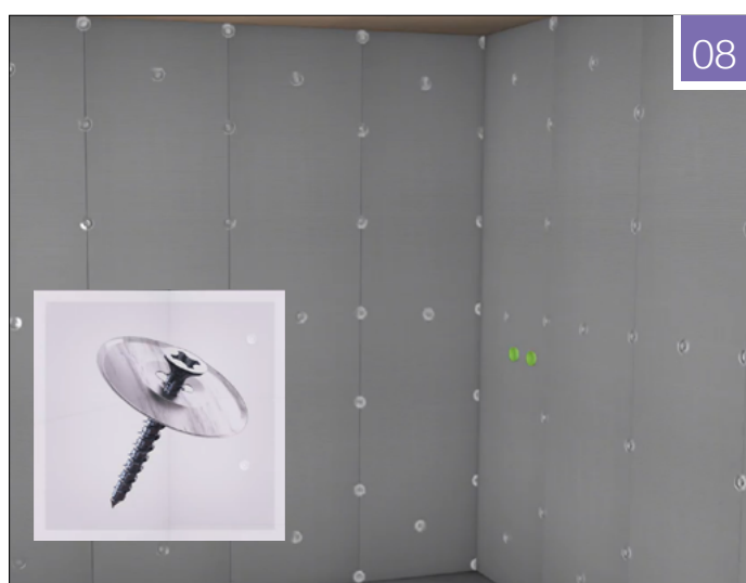
Fig. 08: Fest Jackon Våtromsskrue og Festeskive i hver plateskjøt, med en avstand på 30cm. Det skal i tillegg skrues 3 Jackon Våtromsskruer og festeskiver i senter av hver plate (se illustrasjon).
