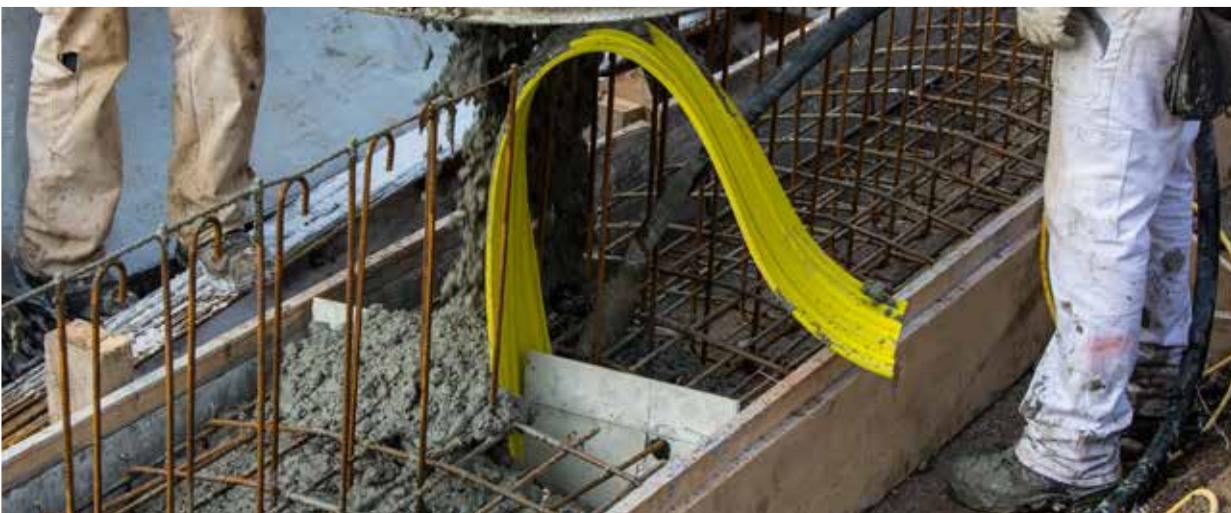
Sika "White Box"-konsept / Vanntett betong
