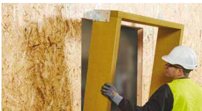
REDAir Link løftes på plass
