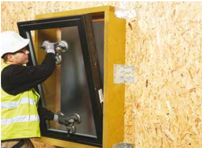
Vinduet løftes på plass i REDAir Link
