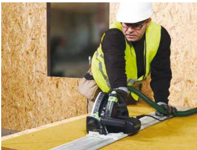
Tilskjæring av REDAir Link Plate med alminnelig håndverktøy
