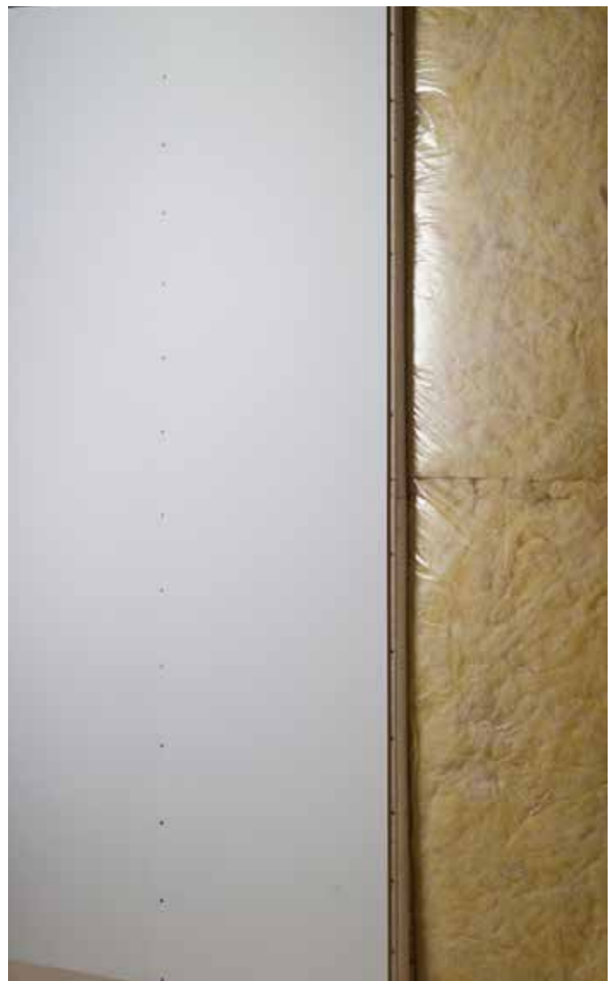
Forestia 3 vegg med grunning
