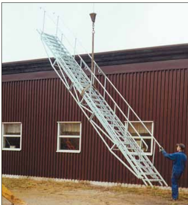
Här är en 30-stegs trappa uppställd till ca 7 m höjd. Höjden kan varieras.
