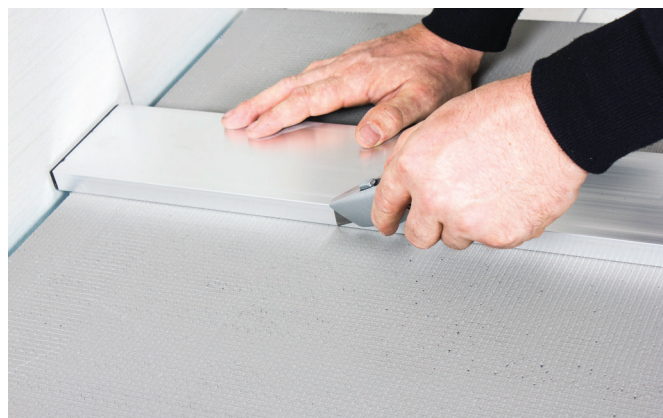
Platene kuttet enkelt med tapetkniv.
