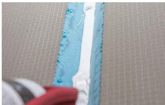
Påfør lim i rørkassens v-spor.
