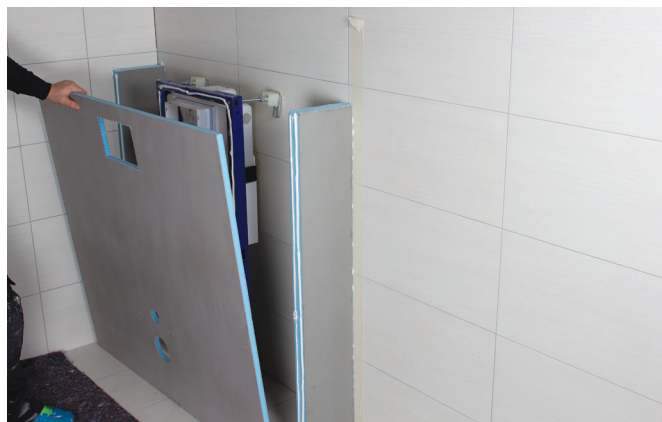
Påfør monteringslim på ramme, vegg og gulv.
