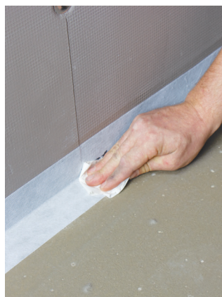
Båndets dekkpapir er todelt – enkel montering. Jobb båndet inn med håndflaten, for god heft.
