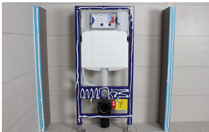
Ta mål og tilpass kassen
