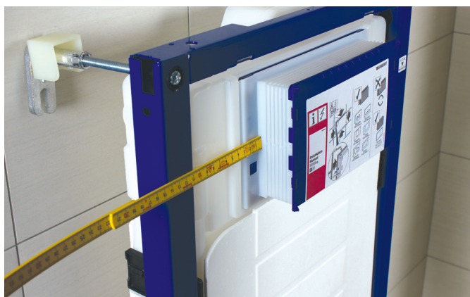
Ta mål og tilpass kassen
