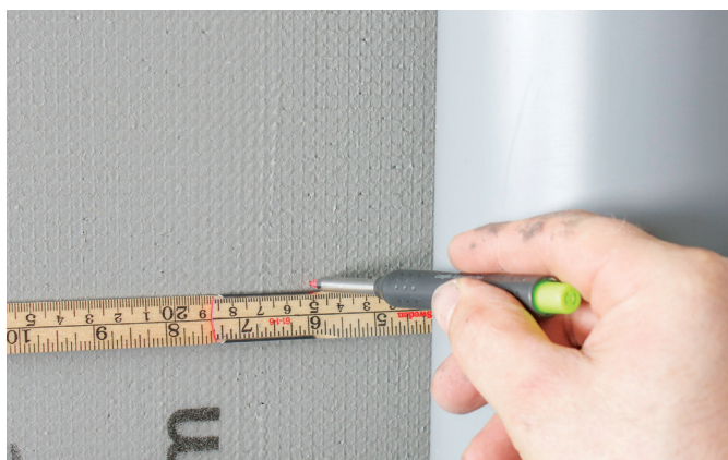
Ta mål og tilpass rørkassen i høyde.
