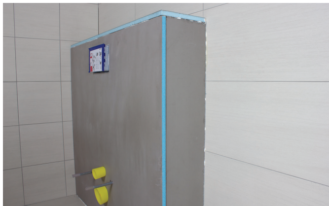
Lag drepsåpning og forsterkning.
