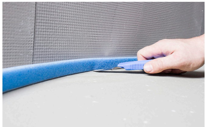
Overskytende ekspansjonsbånd fjernes.
