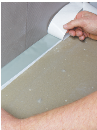
Båndets dekkpapir er todelt – enkel montering. Jobb båndet inn med håndflaten, for god heft.
