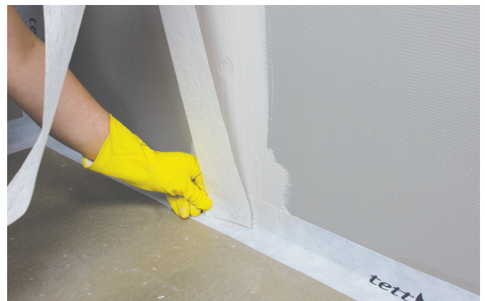
Legg fiberremsen i våt membran.
