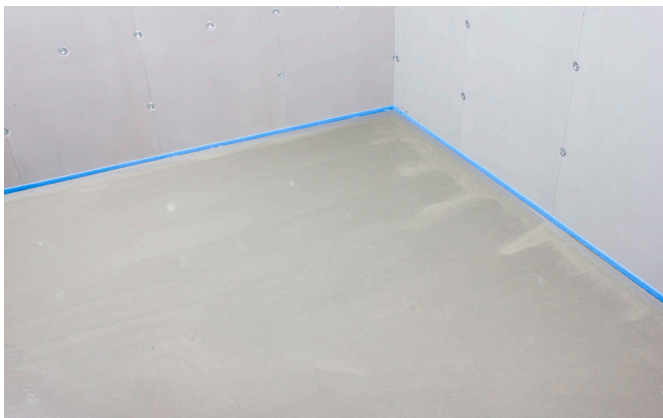
Ferdig avrettet gulv.
