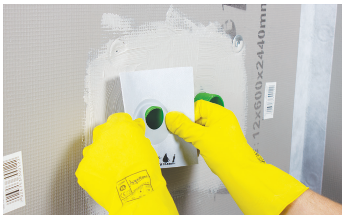
Tre mansjetteen forsiktig på røret.
