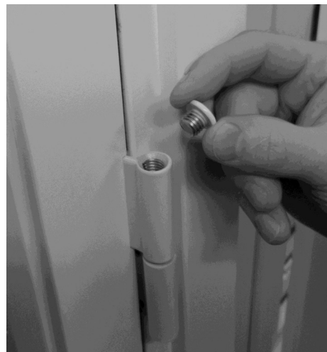
Fig 21. Demontering av dekklokk på toppen av hengsler.
