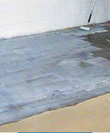
Påføring av Mapeprim SP
