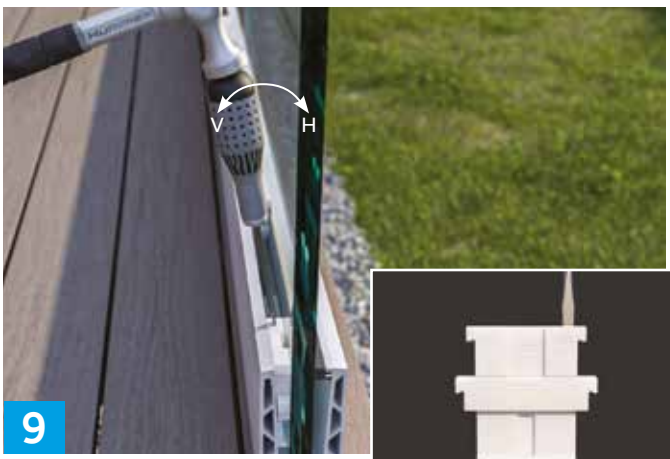
9 Glassene låses ved at øvre delen av låsekilen bankes forsiktig ned.
