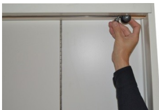
Montering av hjulbeslag/trinse.
