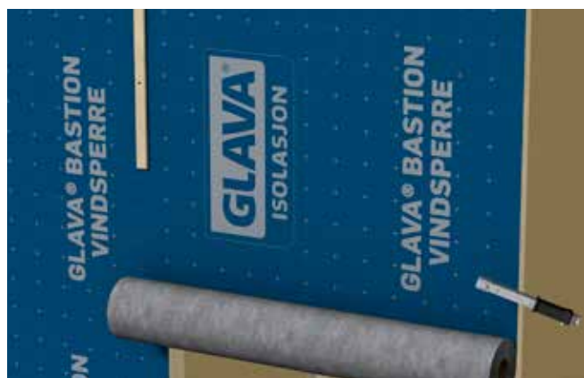
Fig. 35 Vertikal montering av vindsperre
