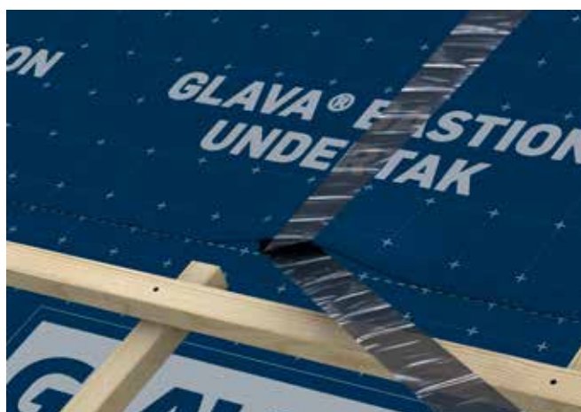
Fig. 8 Fjerning av dekkfolie på klebekanter
