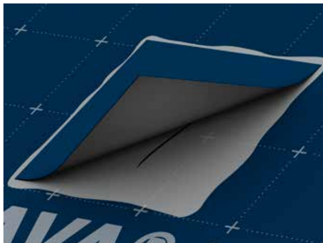
Fig. 22 Reparasjon av skade på Bastion
