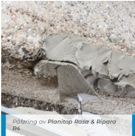
Pushing av overflaten på Planitop Rasa & Ripara R4
