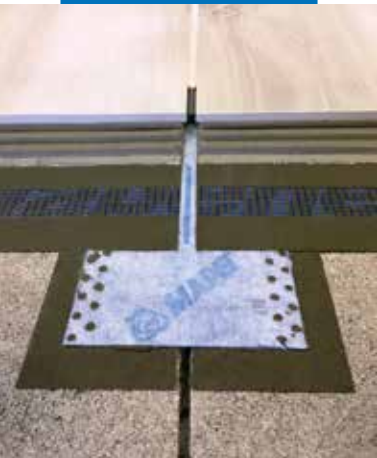
Mapeband Easy lagt over en fleksibel fuge i avrettingslaget
