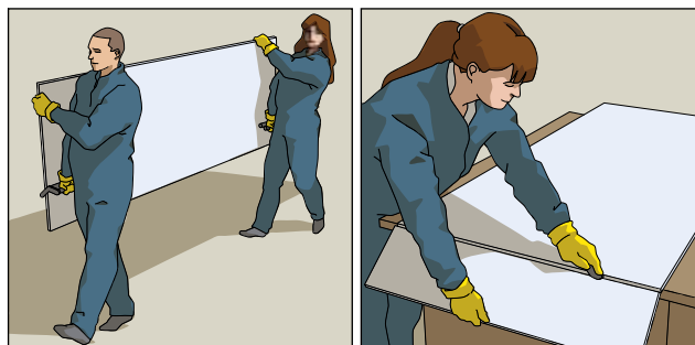
Glasroc-platene bæres vertikalt. Gyproc Bærehåndtak er et godt hjelpemiddel. Platene bearbeides med samme verktøy som gipsplater.
