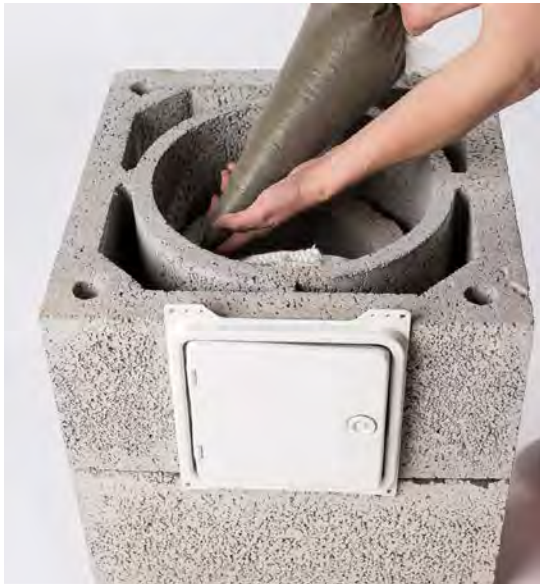
Snoren plasseres rundt stussen på sotluken og det påføres pipemørtel på sotluckerøret.
