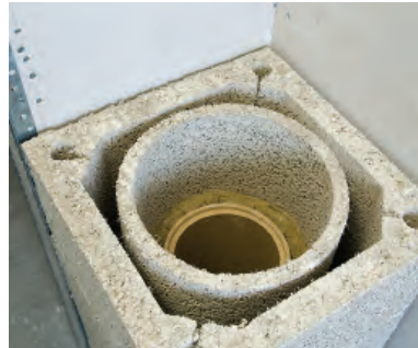
Ytterelement, isolasjon og foringsrør monteres.
