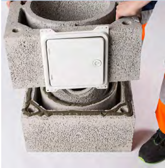
Sotlukeelementet monteres
