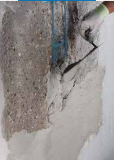
Påføring av Planitop Smooth & Repair med murskje
